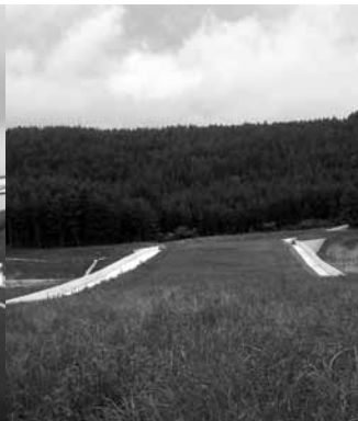
Paso de fauna de Loiti, vistas inferior y superior.
